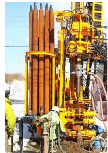
図2 掘削試験の様子
