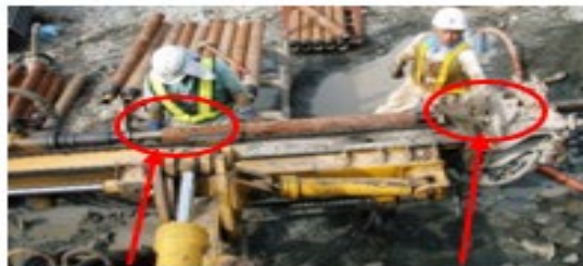
捲込まれ注意箇所
