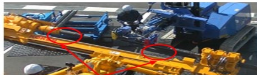
無線遠隔操作式ドリルロッド着脱
